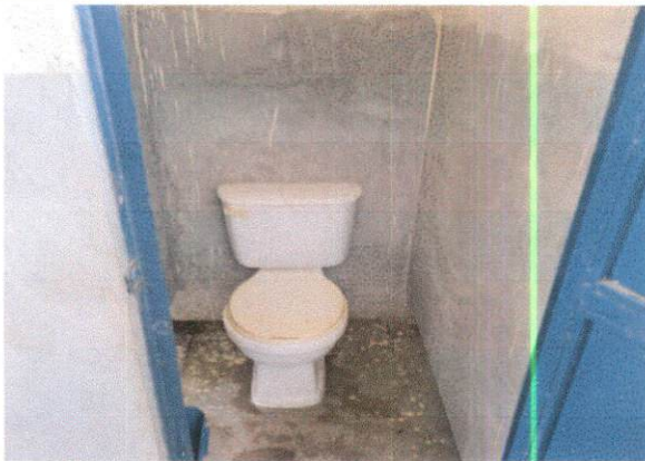
Foto 3: CAMBIO DE SANITARIOS
