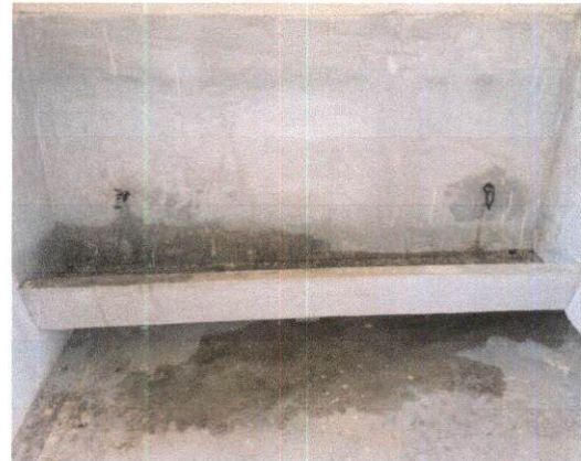
Foto 4: REMOZAMIENTO DE LAVAMANOS
